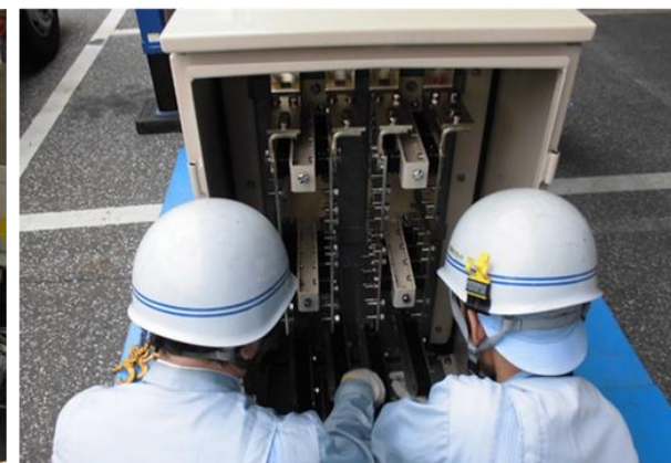
変圧器塔扉外し(同時並行作業)
